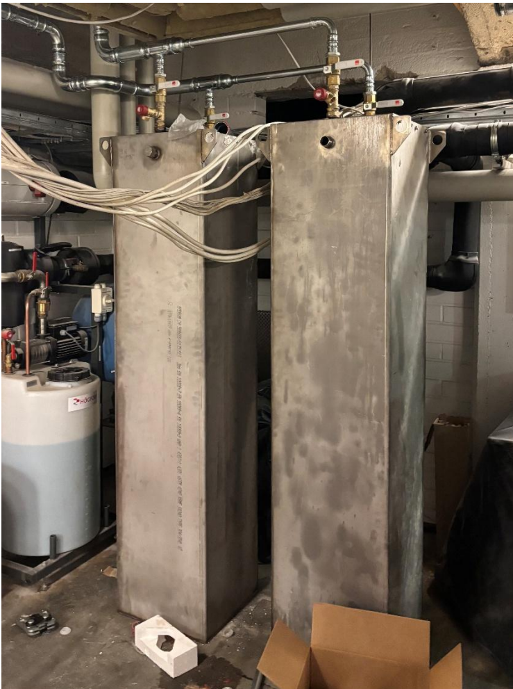
Kuva 4. Kaksi rinnakkaista faasimuutosmateriaalia sisältävää lämpöenergian varastointiyksikköä sijoitettuna todelliseen ympäristöön.
