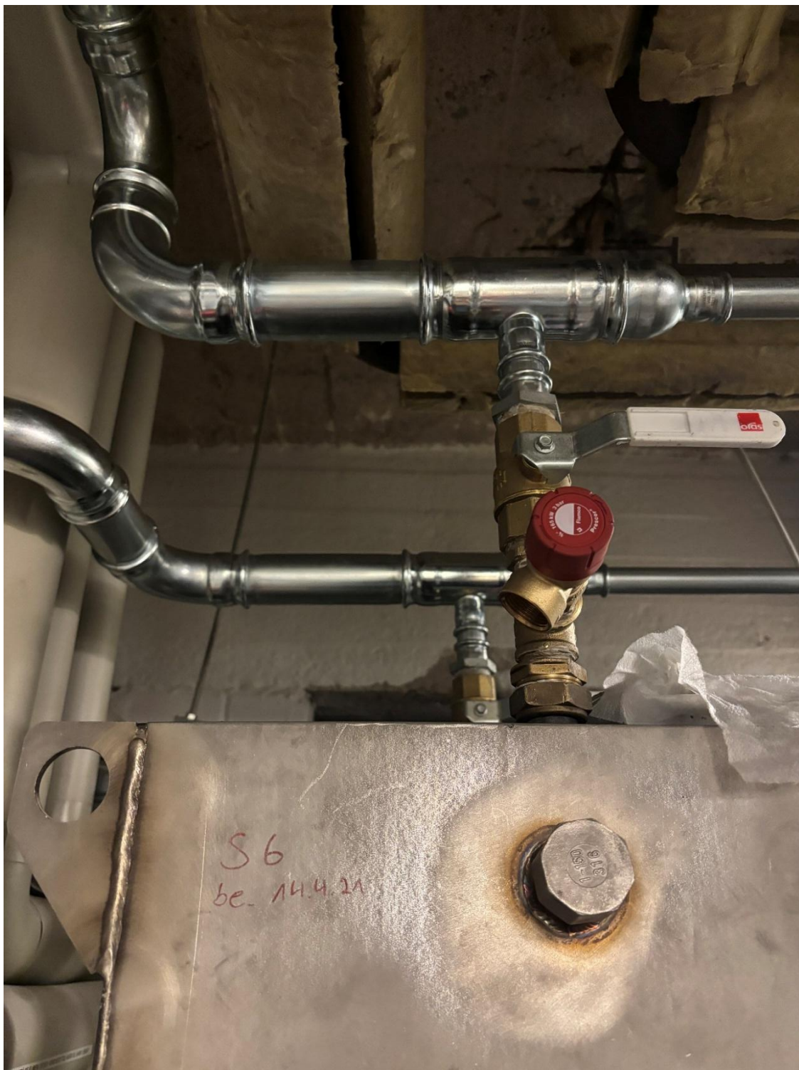
Kuva 9. Lämpöenergian varastointiyksikön putkisto asennusvaiheessa.
