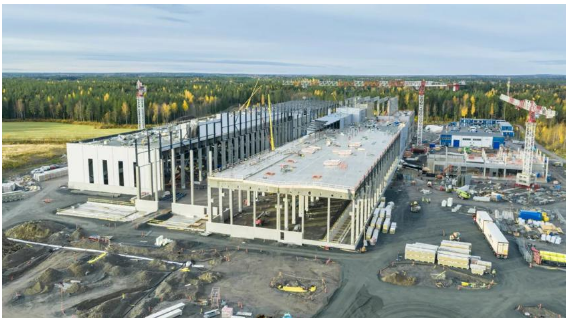
Kuva 1. Uuden tehtaan rakennustyömaa 10/2025. (Hitachi Energy news & Events, 2025).
