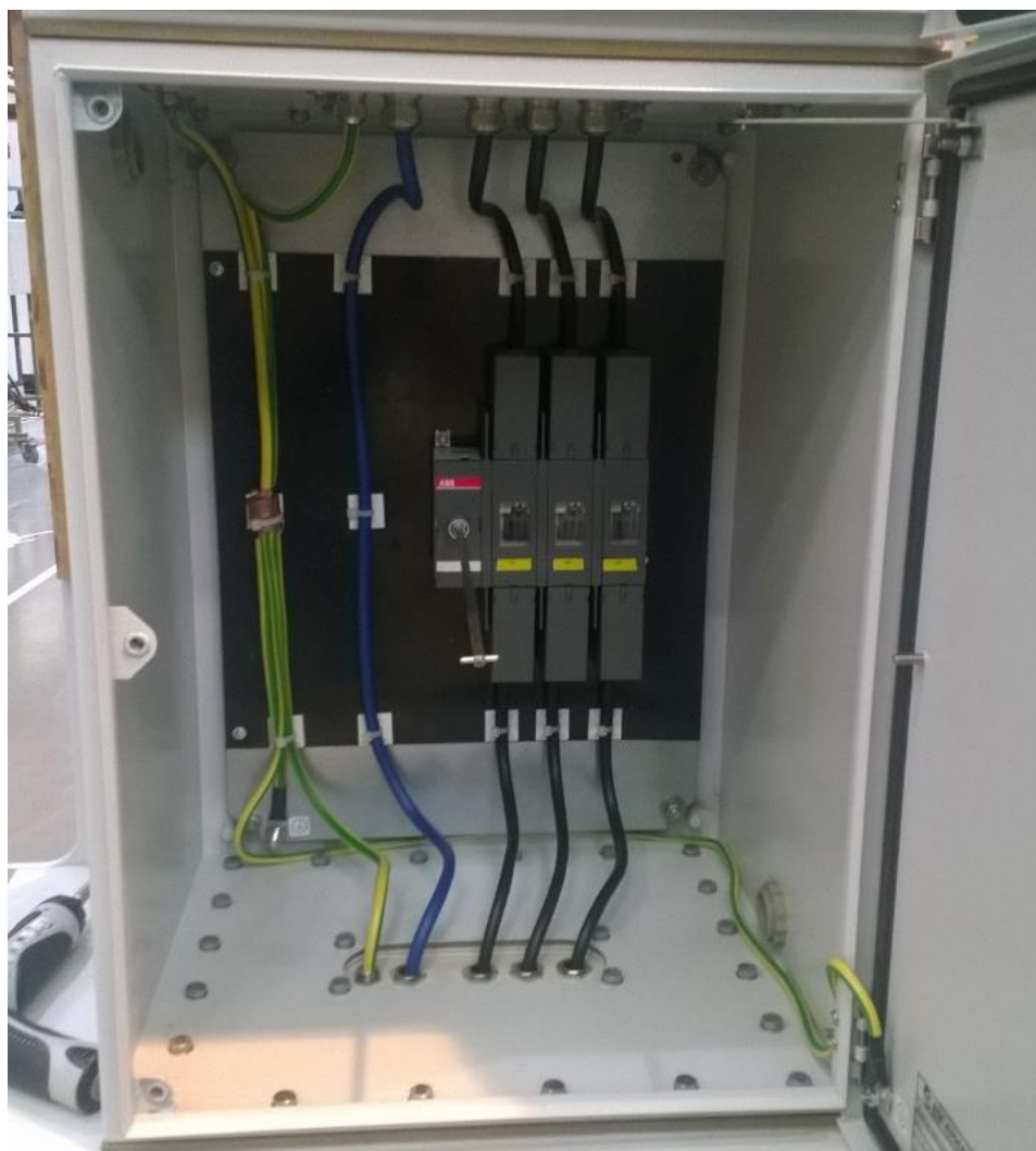
Kuva 5. Kuormankytkimen kotelo
