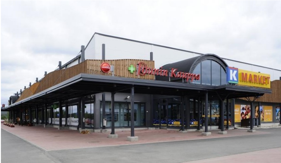
Kuva 2. Jounin Kaupan julkisivu. (Lapin Teollisuusrakennus Oy, 2017.)
