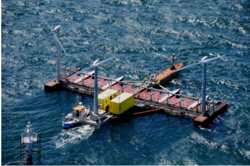
Kuva 6. Poseidon-hybridijärjestelmä, jossa yhdistyvät tuuliturbiinit sekä oskilloivaan runkoliikkeeseen ja OWC-teknoologiaan perustuvat aaltoenergiamuuntimet (McTiernan ja muut (2020)).
