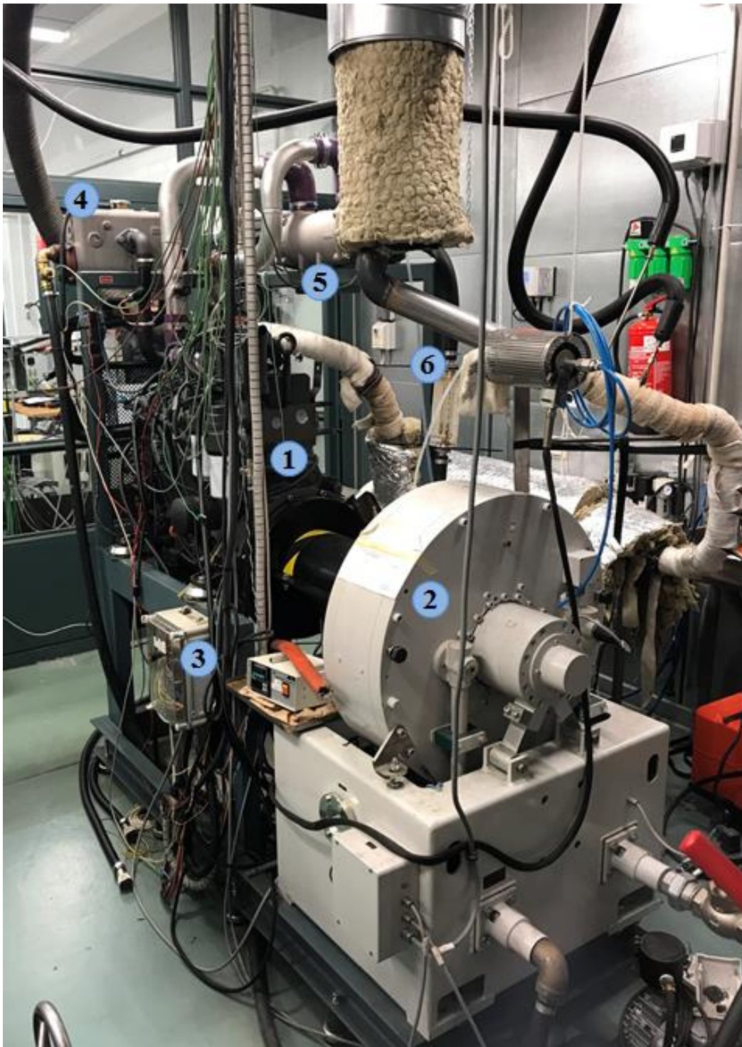
Kuva 2. TB:n moottoriselli ja moottorijärjestelmä. Kuvaan on merkitty: 1) AGCO Power 44 AWI -moottori, 2) Horiba WT300 -pyörrevirtajarru, 3) sähköliitäntäkaappi, 4) lämmönsiirrin, 5) välijäähdytin ja 6) jäähdytysveden virtausmittari.
