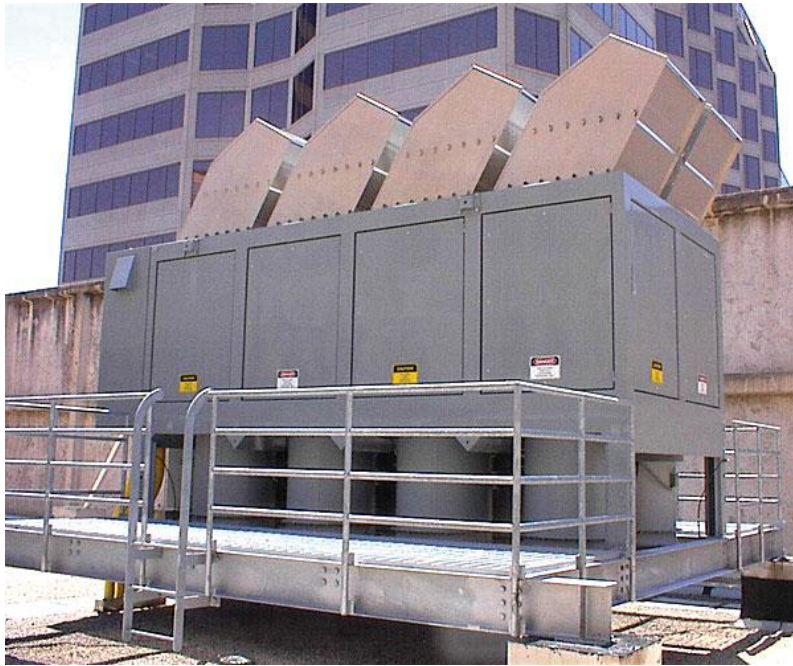
Kuva 13. Avtronin K922A-keskijännitekuormitusvastus asennettuna (Steadypowers 2015).
