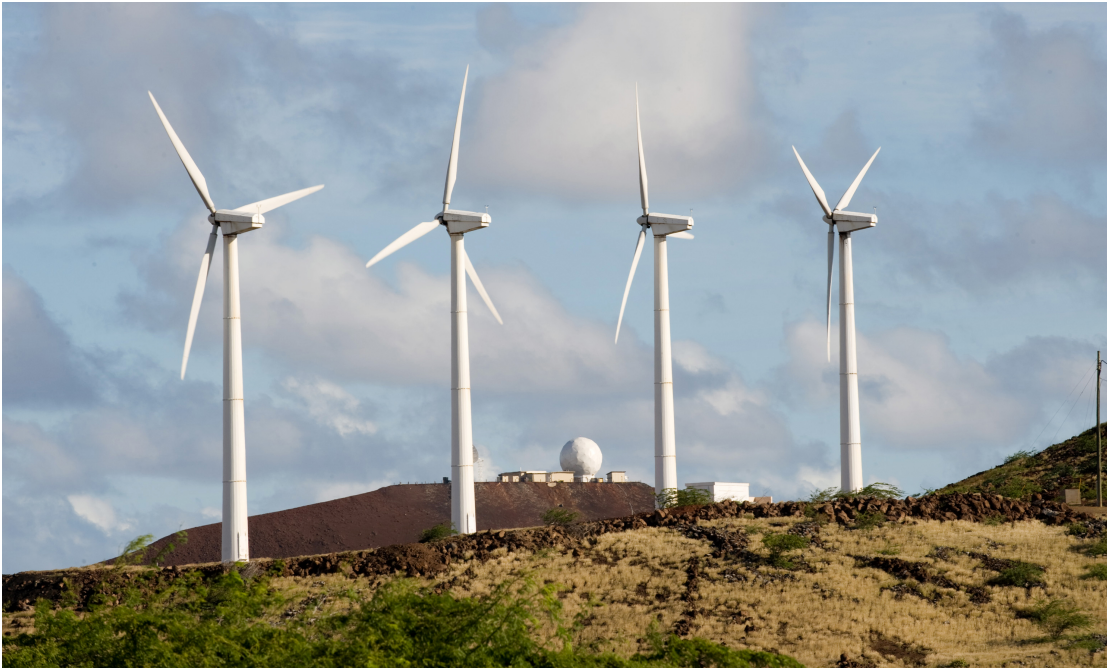
Kuva 10: Betonirakenteinen torni. (Lance Cheung)
