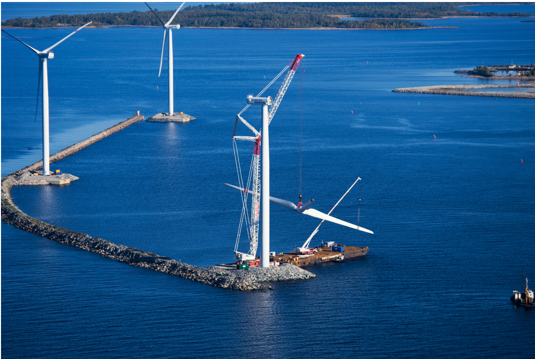
Kuva 14: Roottorin asennus tuulivoimalaan Kemissä (Winwind)
