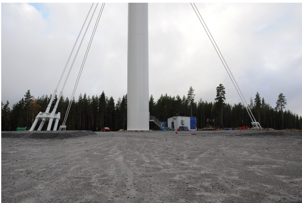
Kuva 9: Harustettu putkitorni Vaasassa. (Norja 2012)
