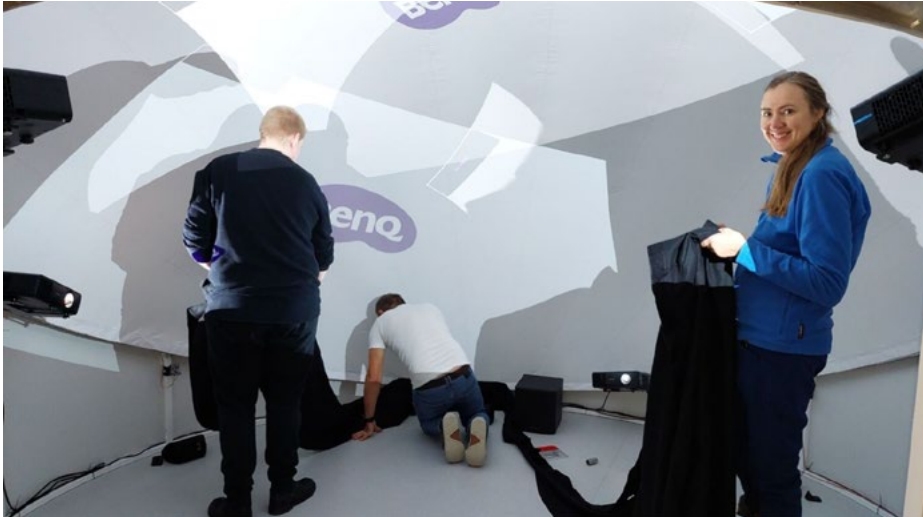
Picture 41. Installing the AV equipment (photo: Martta Niemi).
