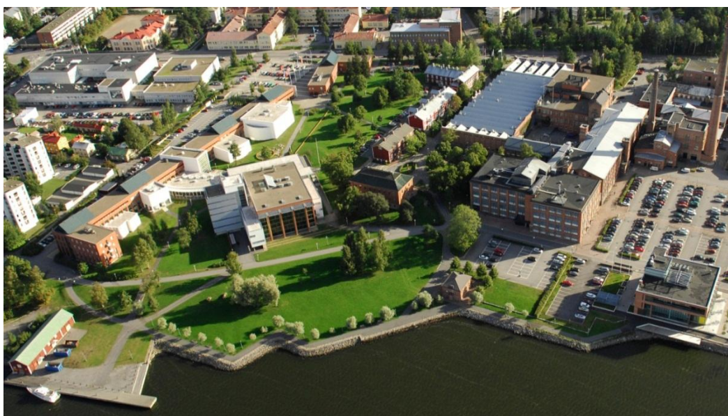
Kuva 8. Kolmessakymmenessä vuodessa vanhan Puuvillatehtaan alueen urbaani kesanto muuntui Vaasan yliopiston kampukseksi, uuden vuosituhatosen tietoympäristöksi (kuva: Vaasan yliopisto).
