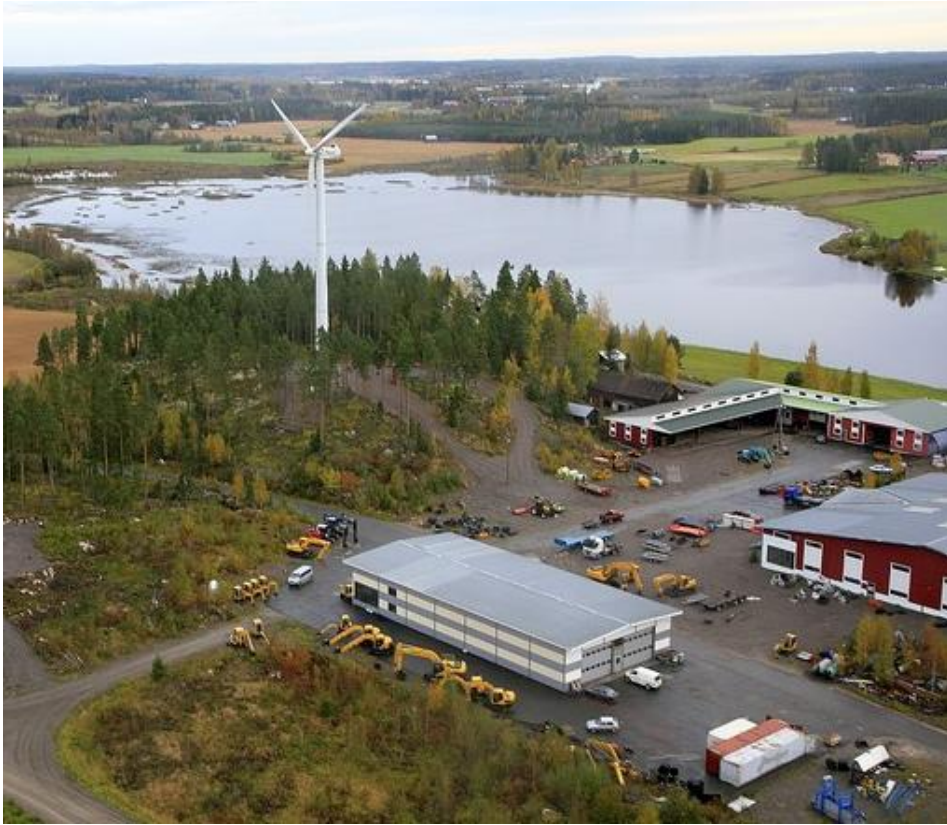
Kuva 28. Riihon 600 kW NEG Micon tuulivoimala (Kuva: Riiho yhtiöt.)
