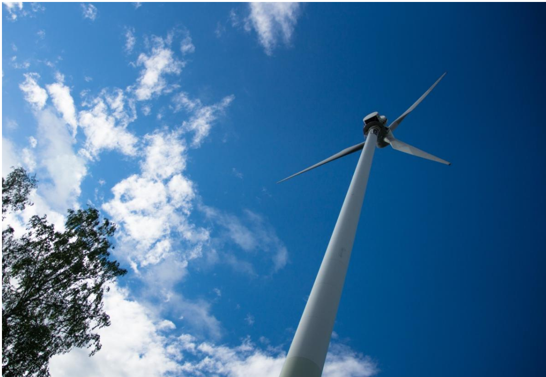
Kuva 29. Hautalan Enercon E30 -voimala.
