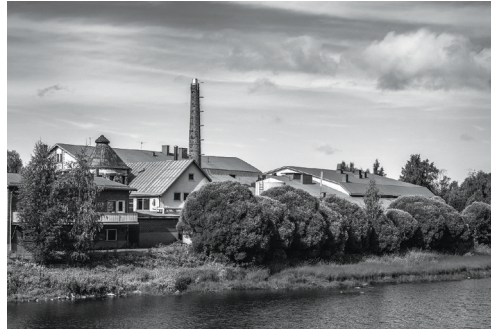
Kuva 4. Meijerirakennus Kyrönjoen rannalla. © Kyrö Distillery
