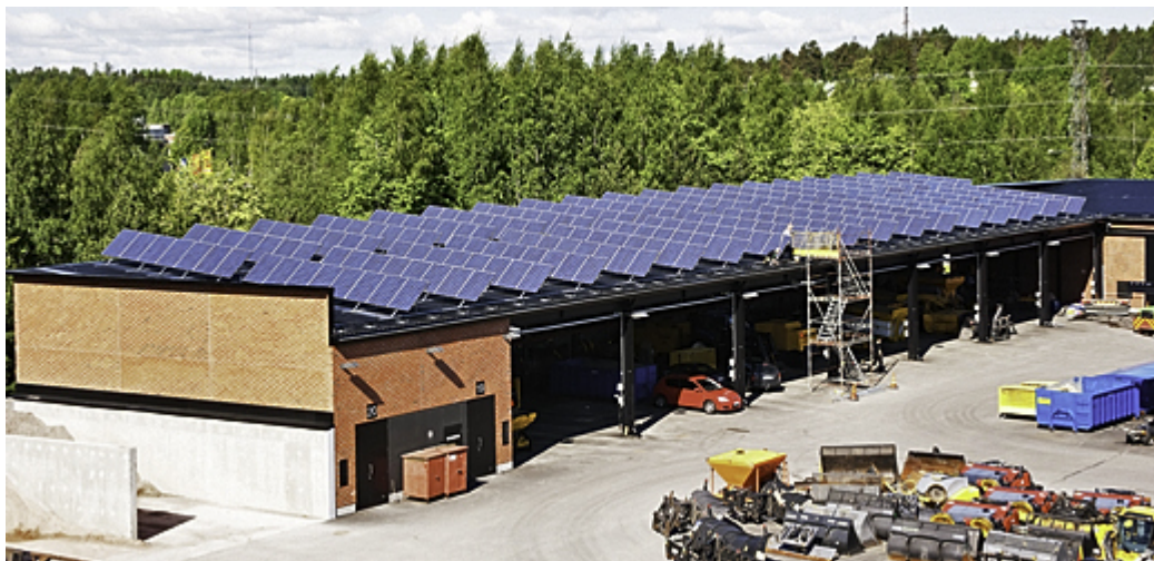
Kuva 55. Espoo Logistiikka -liikelaitoksen varikon katolle asennetut aurinkopaneelit (Patrick Forsblom, 2014).
