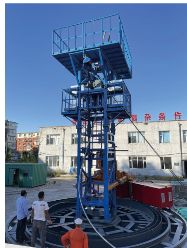
图 15 连续缆管储放设备运行实验
