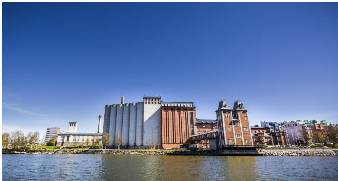
Kuva 3. Vaasan Rantamylllyn betonimaiset viljasiilot Åbo Akademin vieressä (Palomäki 2017).
